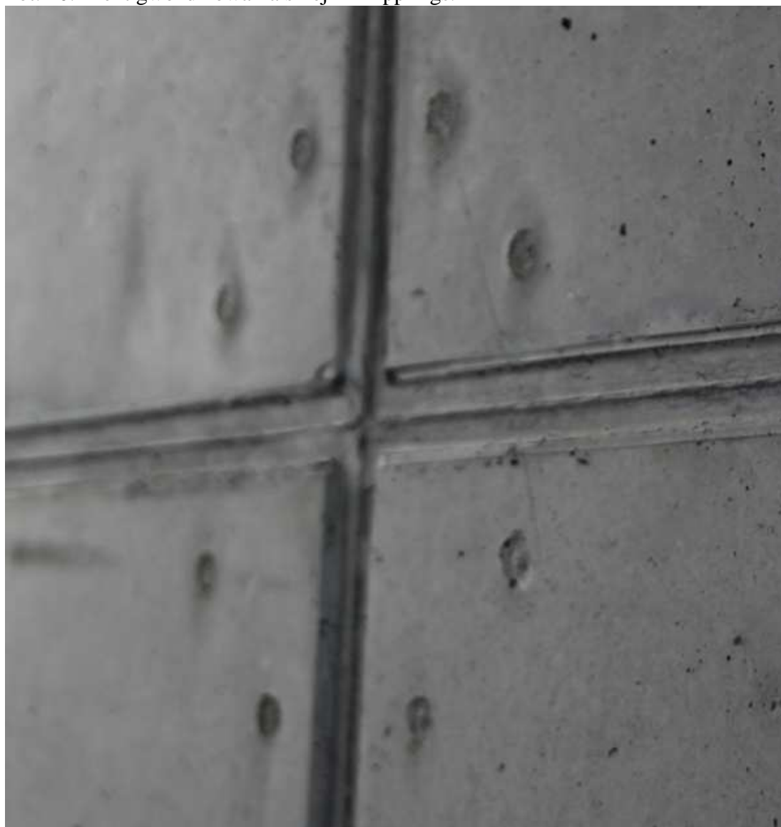
Fot. 10. Efekt gwoździowania sklejki – rippings.
