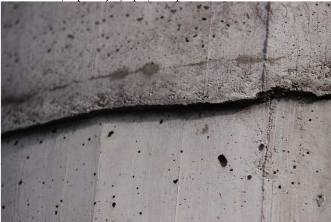
Fot. 6. Przesunięcie płaszczyzny – połączenie poziome.
