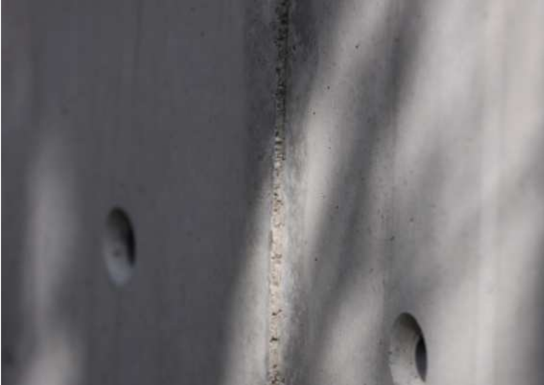
Fot. 5. Przesunięcie płaszczyzny- połączenie pionowe.
