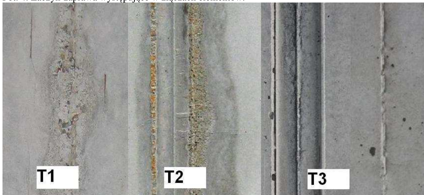
Fot. 4. Zaczyn-zaprawa występujące w złączach elementów.
